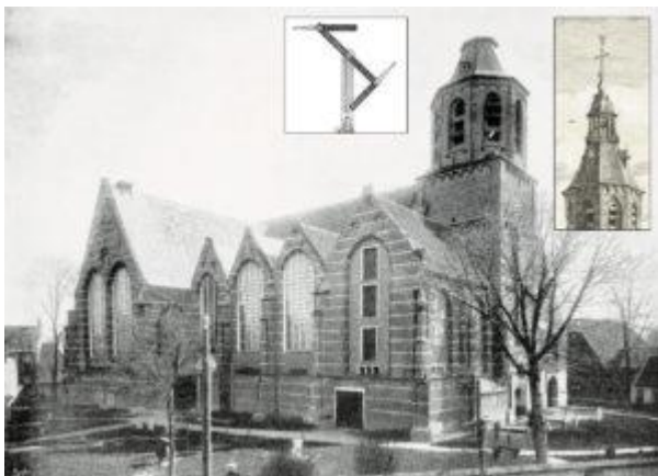
Catharijnekerk Heusden vòòr de Tweede Wereldoorlog in afgeknotte vorm. Collectie Bart Beard. Napoleon liet in 1811 de spits verwijderen voor een optische seinpost, onderdeel van een gtelegraafverbinding tussen Parijs en Amsterdam.
